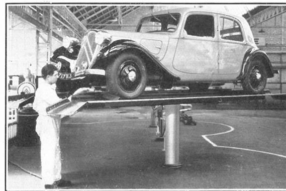
Les postes de graissage sous pression.
